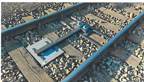
Abbildung 1: Abgeklappte Sh-2-Tafel am Beispiel Gleis 2
